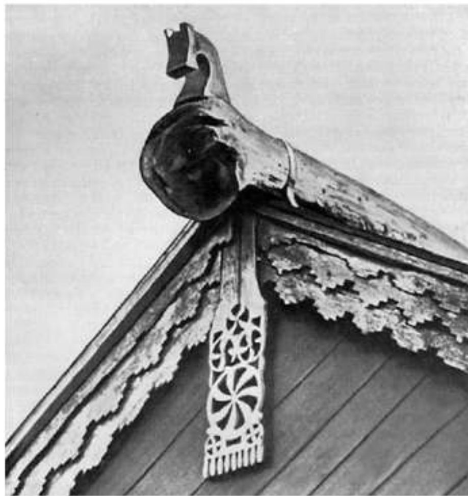
«ГРОМОВЫЙ ЗНАК» ПОД КОНЬКОМ КРЫШИ. Север
